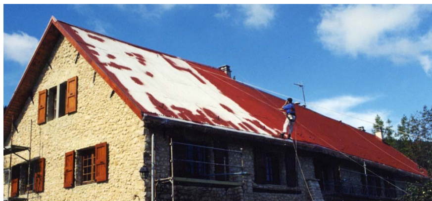
Travaux réali- sés pour : Mr GOUBET Lans en Ver- cors 900m2 Avec garantie De 10 ans
