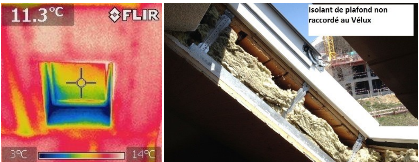
Photo infra rouge d'un vélux. La couleur bleu correspond au pont thermique. Une fois le lambris démonté il est évident que l'isolant n'est pas en contact avec le dormant du Vélux.
