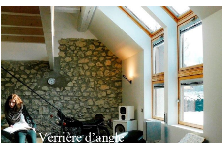
A gauche ouverture à rotation et projection à droite
